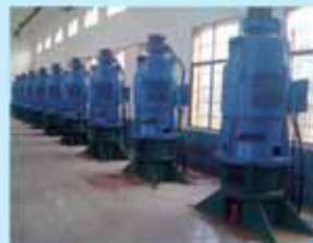
洞庭湖水利工程永丰泵站 Dongtinghu Conservancy Project
